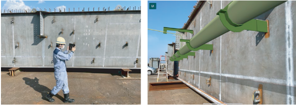
図 13 排水金具の取付け位置の確認
